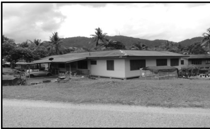
Gambar 2: Rumah A, Pegawai Atasan/ Pekerja Eropah.
